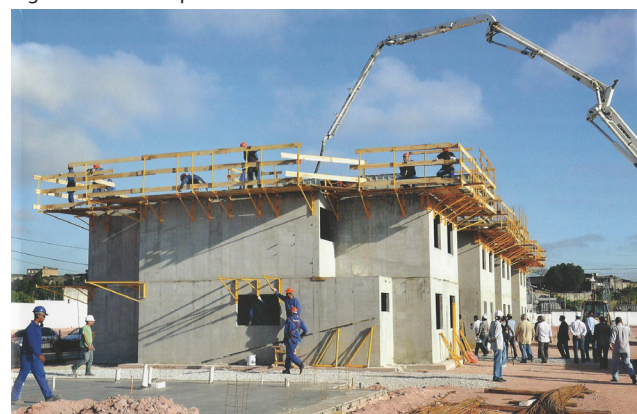
Figura 05: Paredes pré-moldadas em concreto
