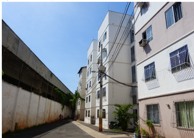
Figura 04: Viaduto junto ao muro do Bairro Carioca
